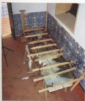
Fig. 117 Aspecto de uma colagem das juntas das pranchas, recorrendo a ripas de pinho que abraçam ambos os lados da prancha. Para o ajuste são usados cingentes metálicos.
