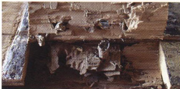
Fig. 115. Pormenor de uma taleira original da junta danificada pelo ataque de caruncho e térmita. Este orifício foi preenchido com um pequeno parquet de madeira sã, e o segmento levantado em "tampa" foi reaproveitado e recolocado por cima.
